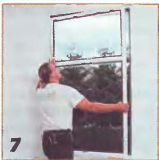
Устанавливают в оконный проём изготовленную по месту деревянную раму.
