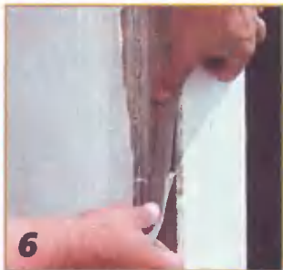
..., а также следы сгнившего дерева и раствора. Затем в откос вдавливают набивочный шнур.
