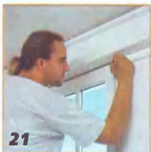
21 Нащельники крепят и изнутри. Но сначала определяют их длину.
