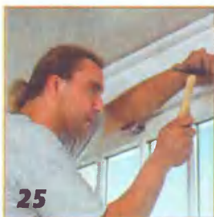
25 Приклеенные нащельники дополнительно закрепляют гвоздиками.
