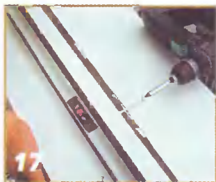
17 Подоконник крепят к раме шурупом, ввёртываемым снаружи.
