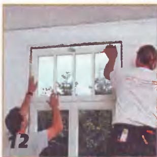
Откидывающуюся вниз фрамугу вводят сбоку в петли.
