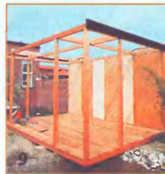
После установки щитов обшивки стен балки верхней обвязки зашивают декоративными карнизными досками.
