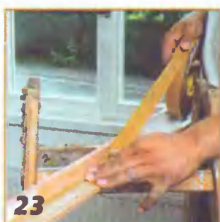
23 С тыльной стороны к нащельникам приклеивают двухстороннюю клейкую ленту.
