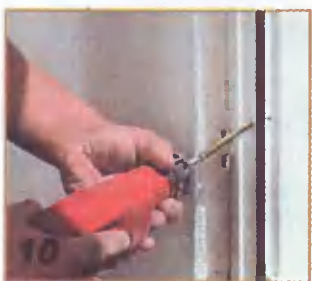
Выверенную раму закрепляют шурупами, ввёртываемыми глубоко в кладку.
