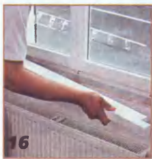
16 Подоконник прикладывают к раме. Если он сделан из твердого дерева, в нем сверлят отверстия под шурупы.
