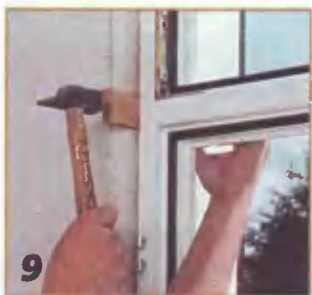
9 Точную выверку рамы производят с использованием клиньев.
