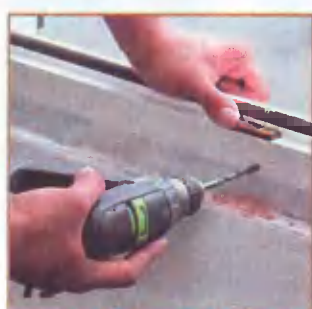
15 Чтобы закрепить деревянный подоконник, изнутри в раме сверлят небольшое отверстие.
