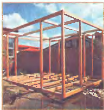
После того, как сборка каркаса завершена, можно приступать к настилке пола, монтажу щитов обшивки стен и навешиванию дверей.
