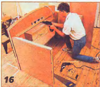
Свинтив заднюю и боковые стенки длинными шурупами, несущие конструкции «центра» прикрепили к полу с помощью металлических уголков.
