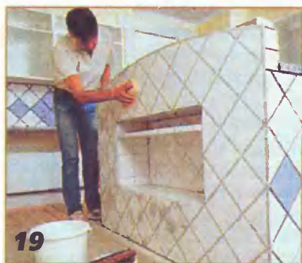
Межплиточные швы затерли специальным раствором белого цвета.
