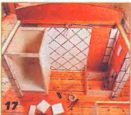
Цоколи для внутренних тумб «центра» также прикрепили к полу с помощью металлических уголков.
