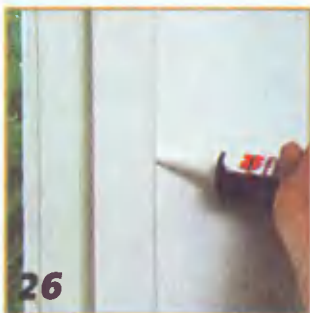
26 Соединительные швы уплотняют опять же акриловым герметиком.
