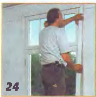
24 Швы между рамой и откосом укрывают нащельниками, образуя из них рамку.
