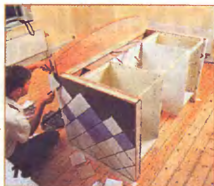
Внешние поверхности боковых и задней стенок облицовали такой же керамической плиткой, как и стены помещения.
