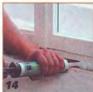
14 Шнуры уплотняют силиконовым или акриловым герметиком.
