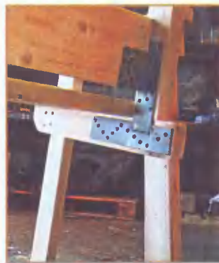
Вид на скамейку сзади и снизу. Хорошо видны металлические косынки, с помощью которых прикреплены бруски сиденья и спинки.
