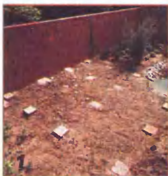
Фундамент для постройки сооружают из врытых в землю бетонных блоков, тщательно выверяя их опорные поверхности по уровню.
